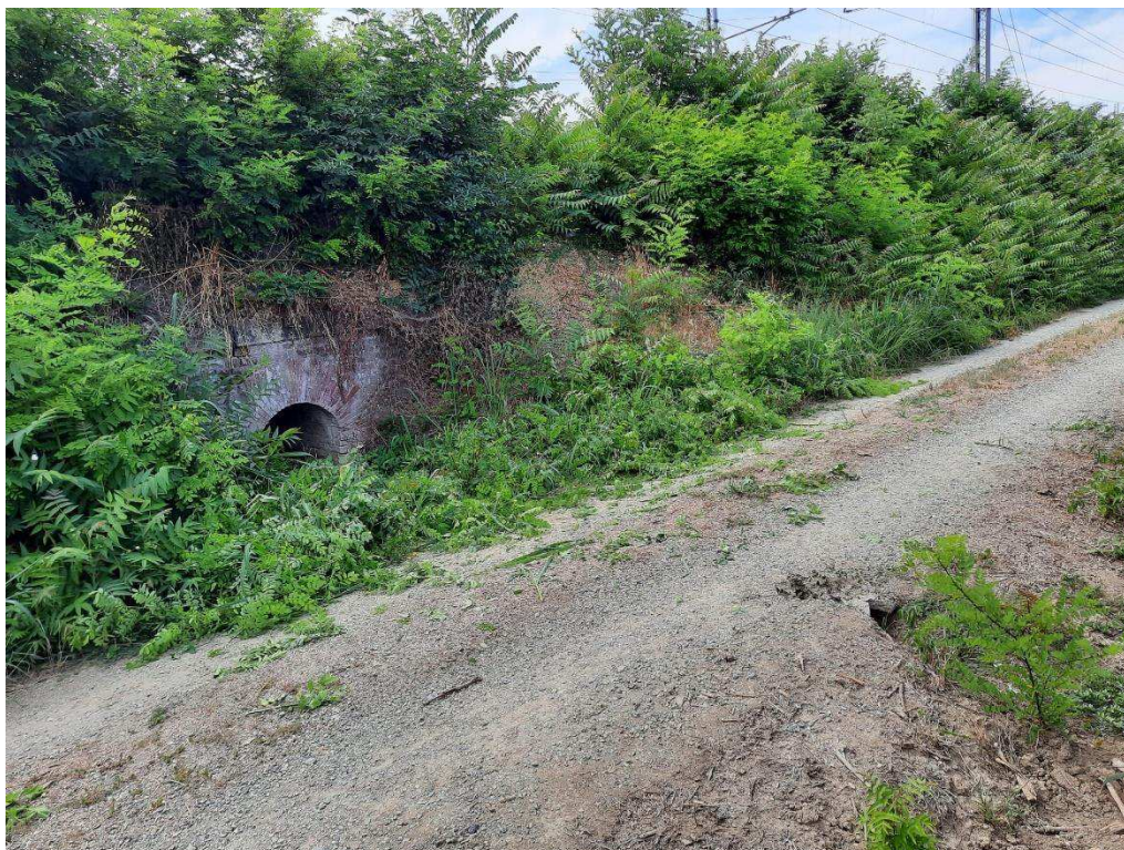
Fotografia 5 – Fornice 1: vista dal lato in cui è prevista la posa della tubazione in PVC DE710 e la realizzazione del pozzetto in c.a. e della paratoia (1 di 2)
